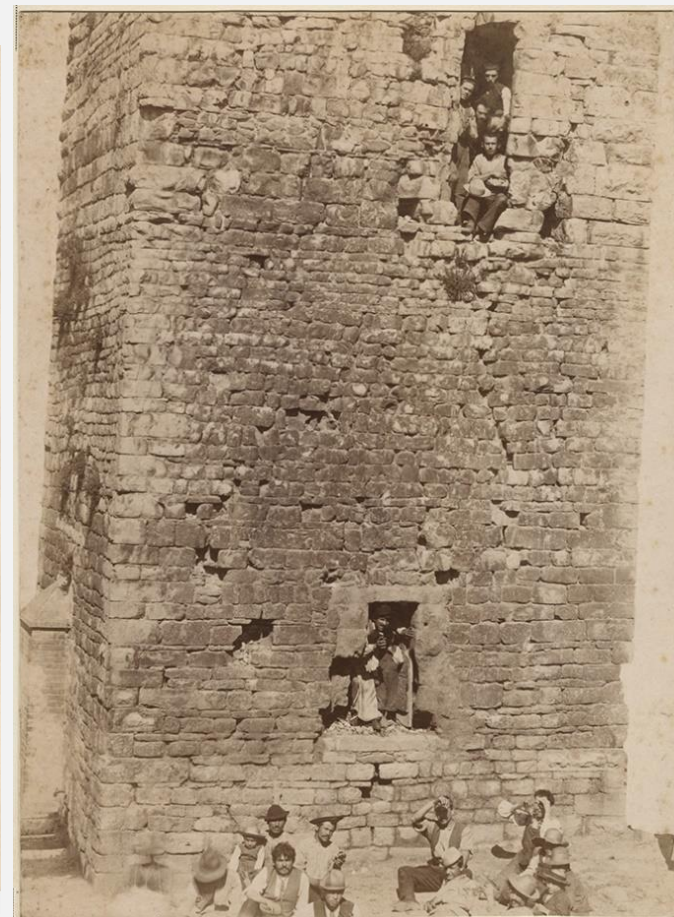
Bibbiena, Tarlati palace. Torre dei Socci tower, around 1880.
